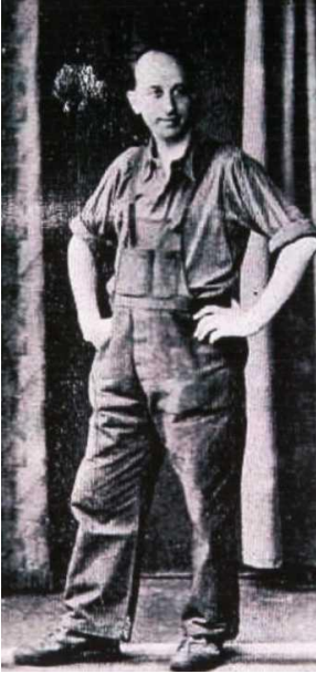
Pierre de Porcaro bei der Arbeit
