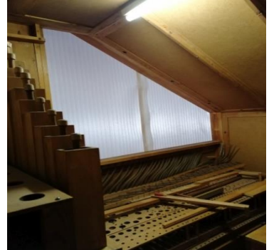
... und nach dem Ausbau der Pfeifen.
