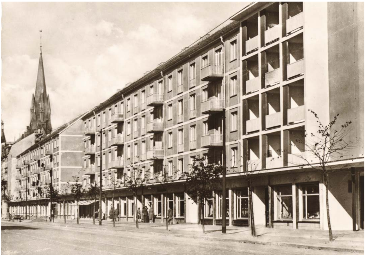
Die Borsbergstrasse 1961 mit dem alten Kirchturm
